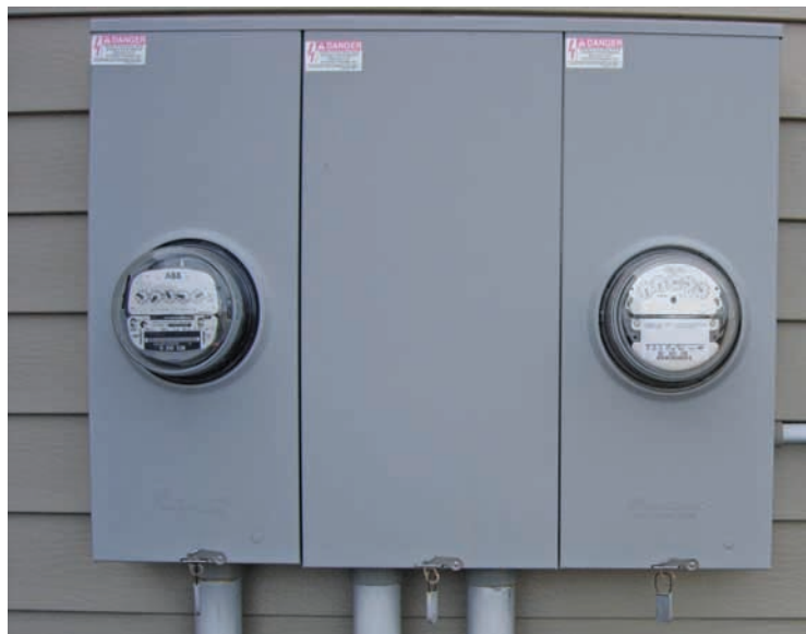
Dual Meter Socket
